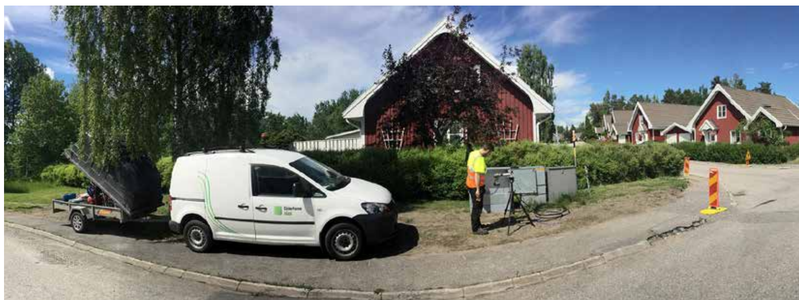
Så här kan det se ut när Söderhamn Nära dyker upp och installerar fiber i ditt område.
