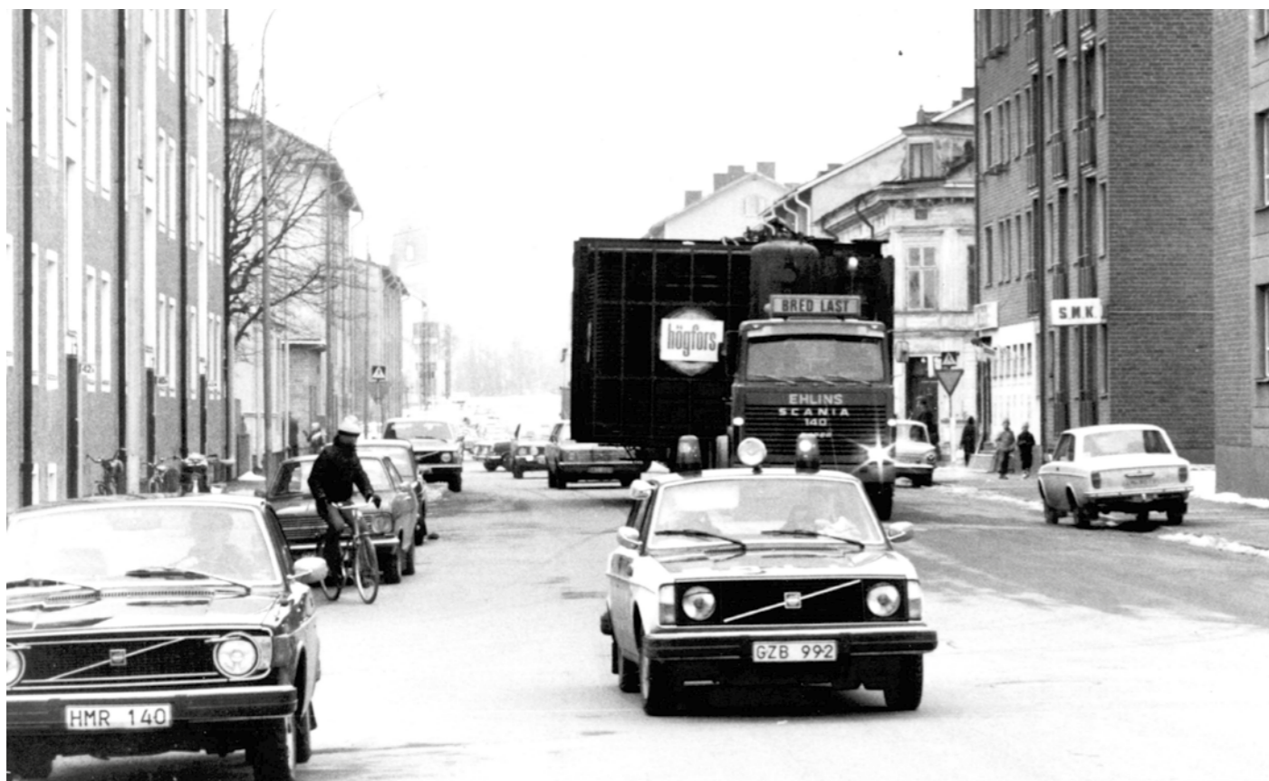
Hetvattenpanna på väg till värmeverket 1977.
