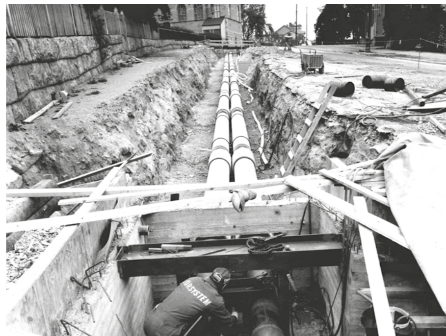
Fjärrvärmeledning på Norrtullsgatan 1974.
