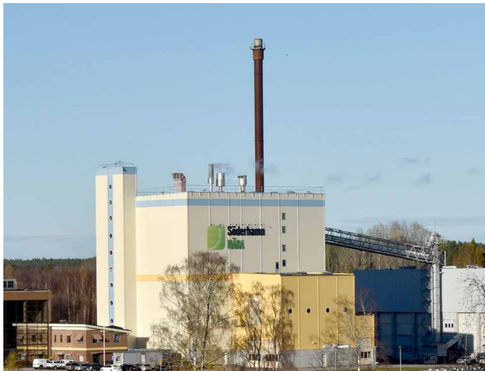
Kraftvärmeverket på Granskär producerar såväl el som värme.
