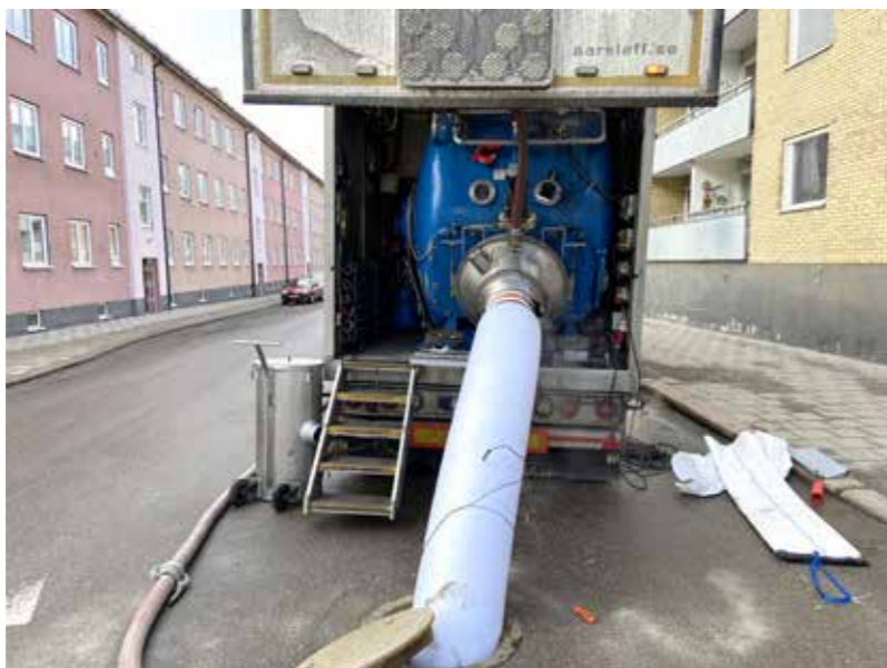
Strumpinfodring av avloppsnetet är ett av de synliga projekt som kommer att kunna påverka framkomligheten.
