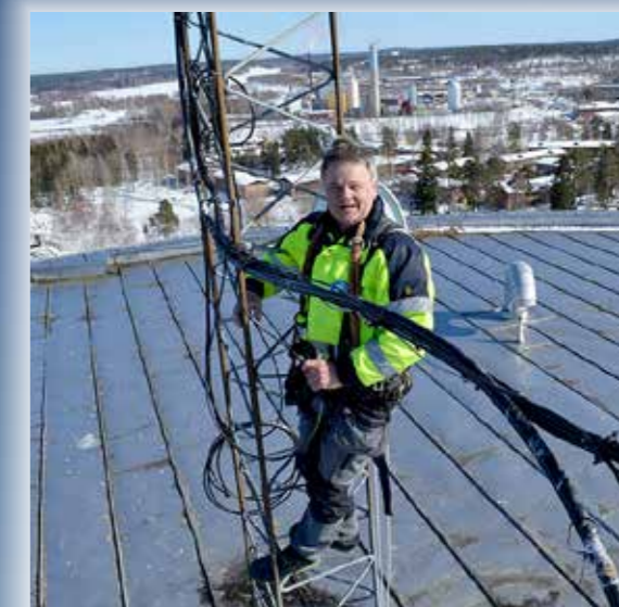
Anders Brolin, tekniker på Elia anlitas för att sätta upp antennen.
