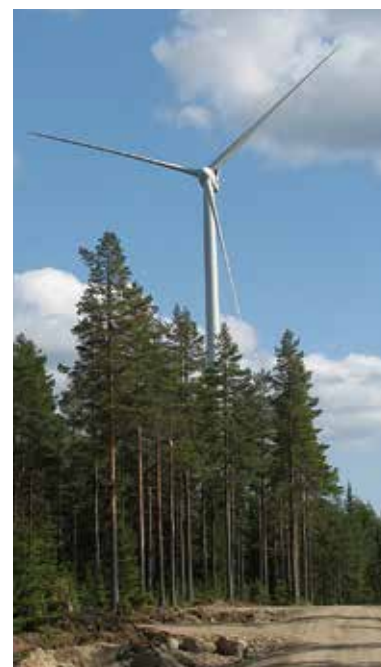
Samkrafts vindkraftverk i Gränn-sjön, Nordanstigs kommun.
