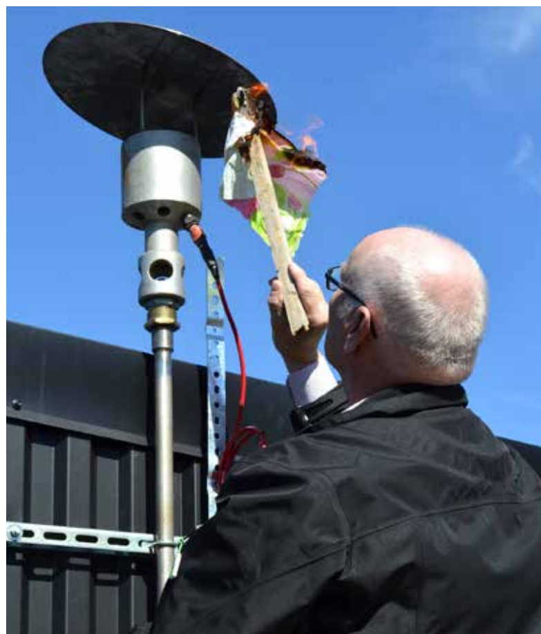
Gasen som produceras måste enligt reglerna facklas i väntan på att den kan tas omhand. Styrseledamoten Ove Söderholm, kontrollerar att den fungerar som den ska.
