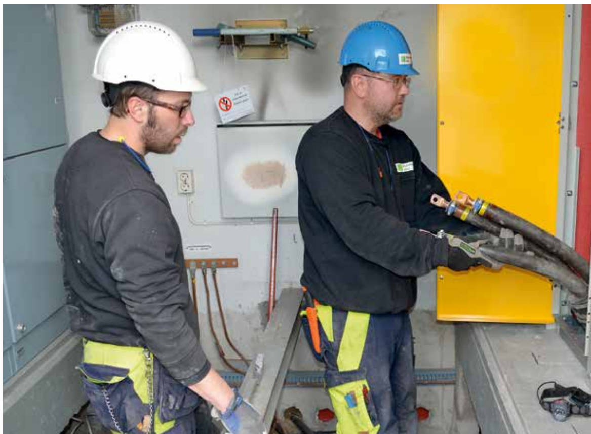
Lars Bodin och Magnus Lindberg byter ut det gamla ställverket på Stamvägen.
