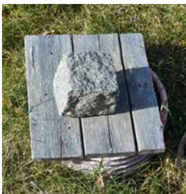
Bengt Nyboms avstängning till det kommunala vattnet. Själva vattenledningen ligger frostfritt på en dryg meters djup.
