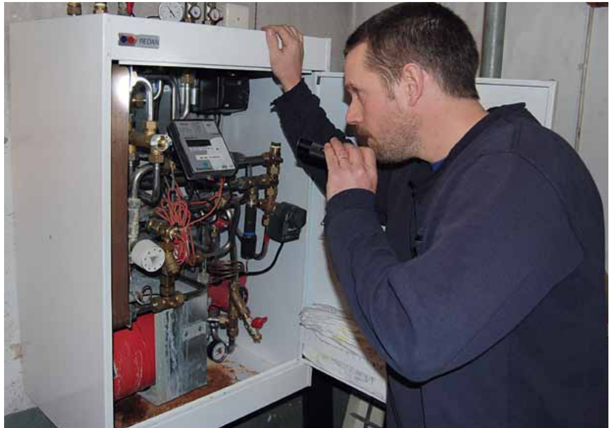
Det är sällan en värmeväxlare går sönder men om det sker, är det en enkel sak att byta ut den.
