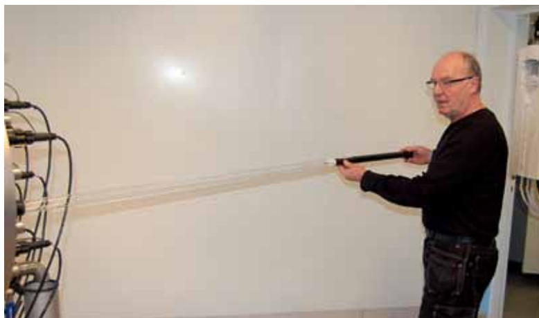
Ove Sundgren kontrollerar lysrören. De beräknas lysa 12 000 timmar innan de blir för svaga och måste bytas ut.
