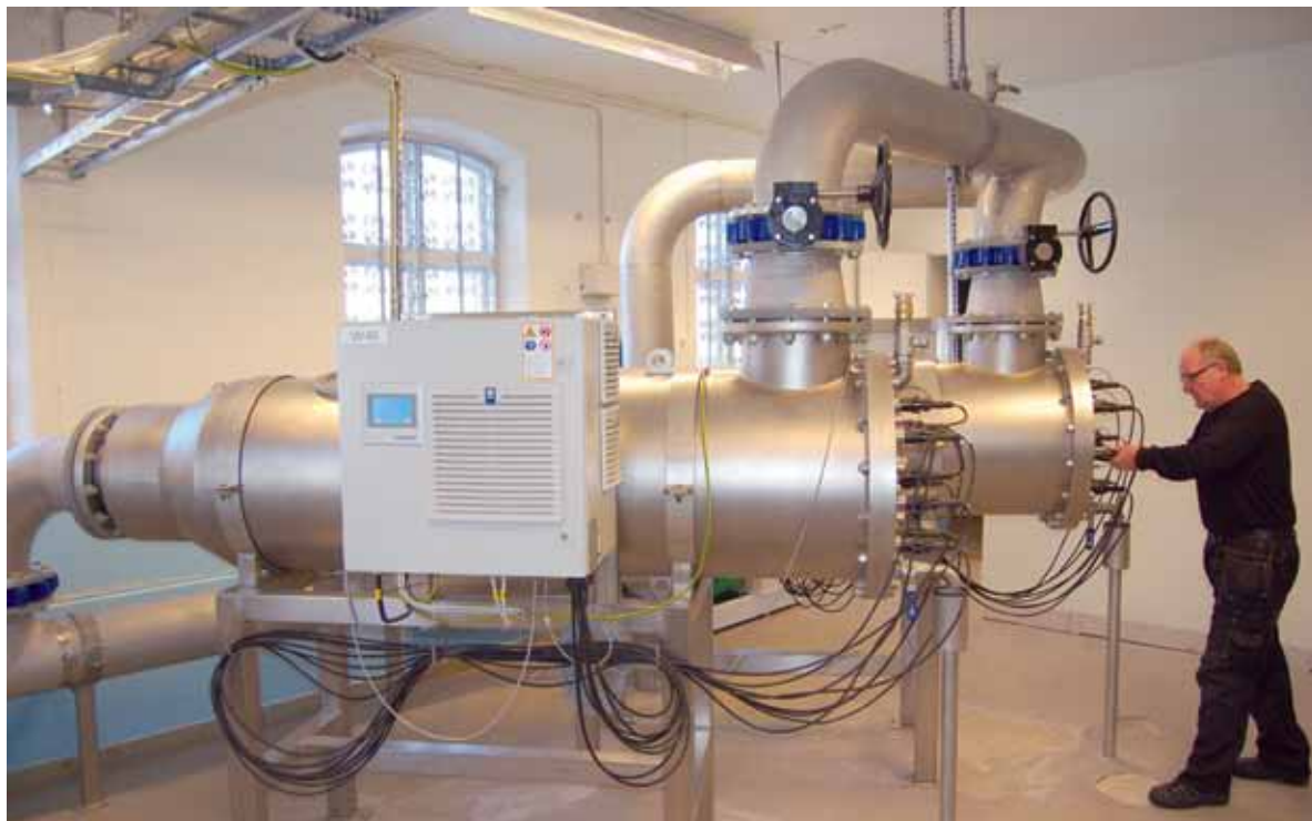
Vattnet kommer in i via ett rör genom UV- filtrets kortända. Blixtnabbt rinner det förbi UV-lamporna och ut genom ett rör i toppen avfiltret.
