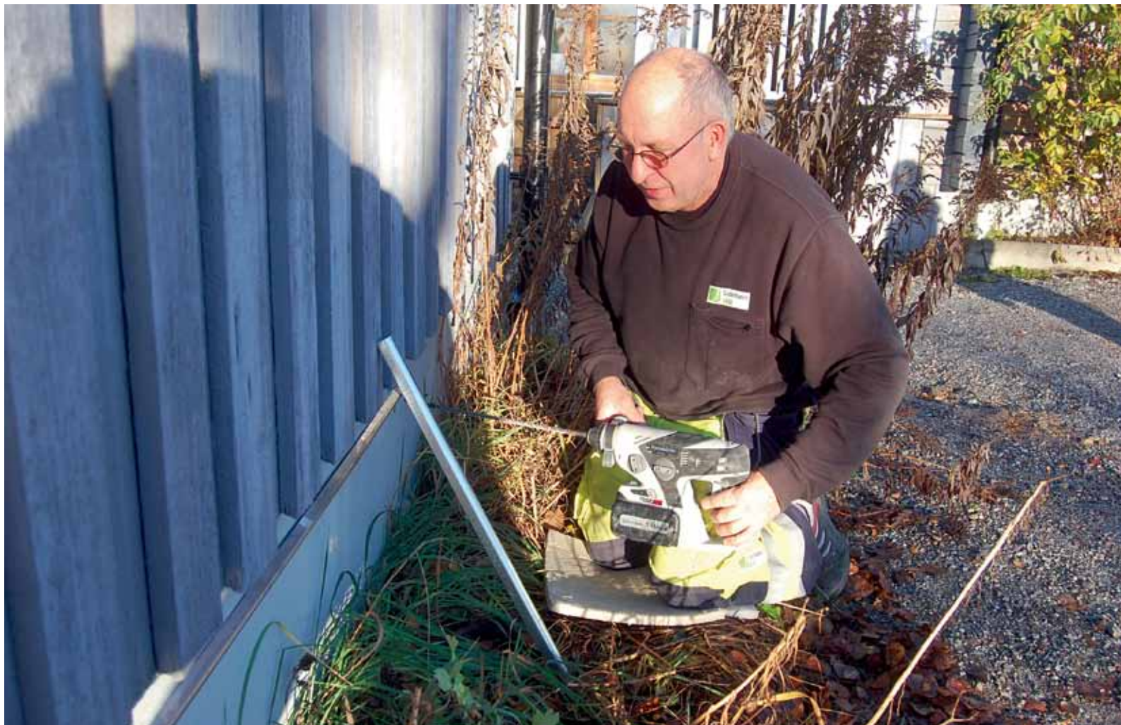
Sten-Björn Sköld installerar fiber i hushållen.
