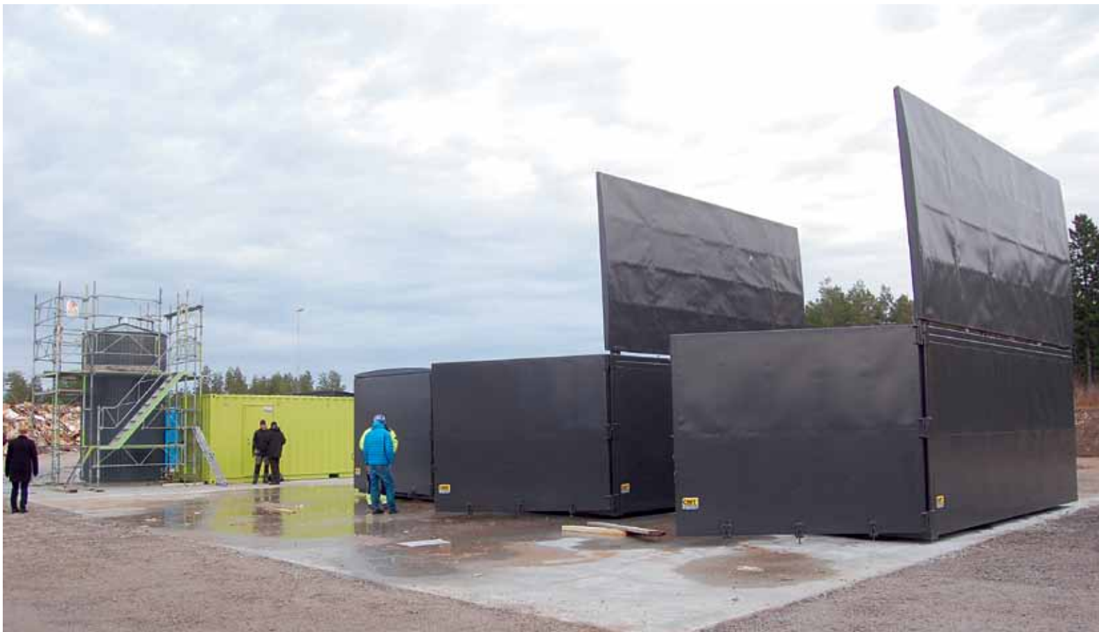
Biogasanläggningen på Långtå är på plats och de första testerna pågår. I förgrunden ser du containrarna som ska innehålla matavfall.
