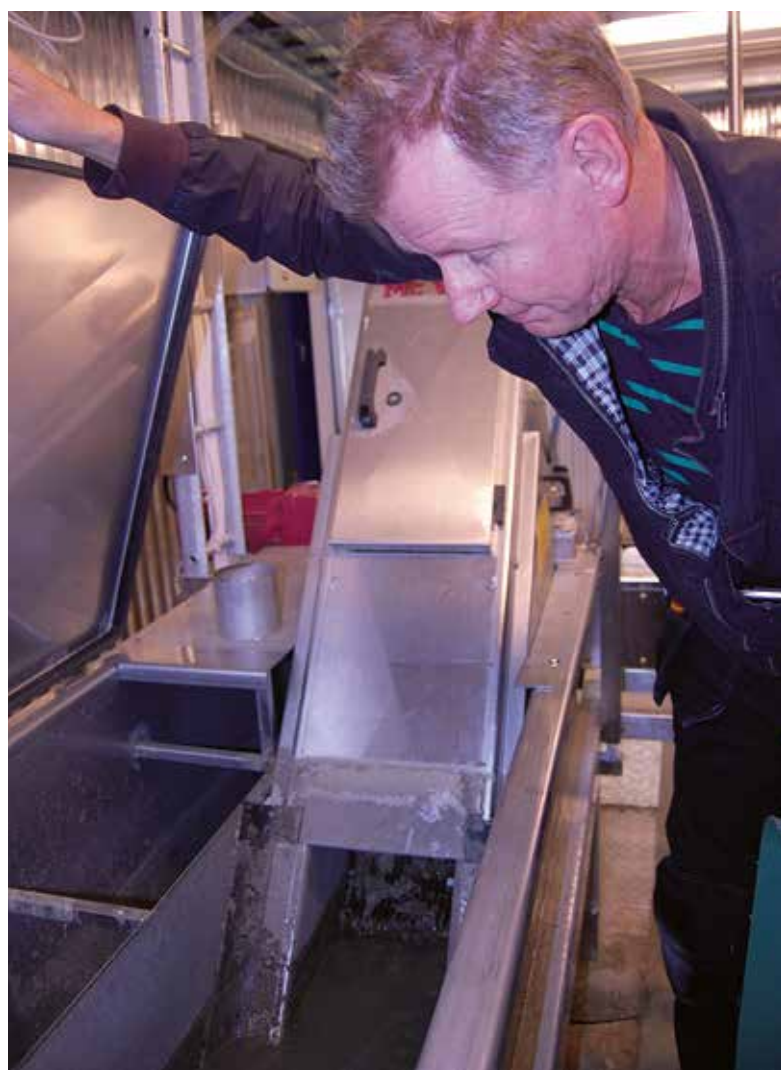
Gunnar Ericsson leder renoveringsarbetet i reningsverket.
