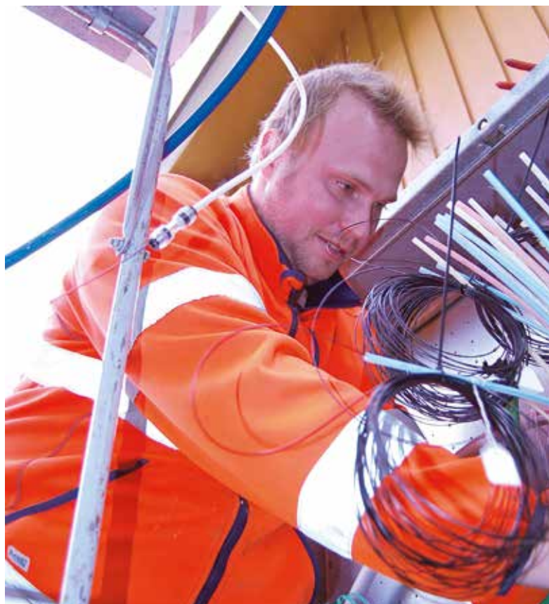
Mikael Walter från MB Gräv & Last installerar fiber till en villa i Vågbro.
