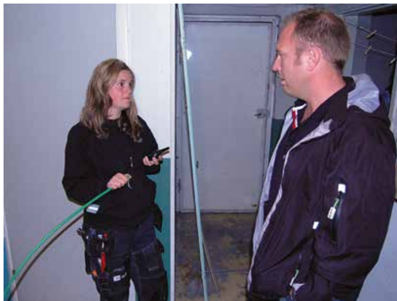
Kabeln blåser man in i hushållen med hjälp av tryckluft. Marie Englin från Långbo Datanät, här tillsammans med Erik Thyr från Söderhamn NÄRA, tar emot kabeln som kommer från kopplingskåpet.
