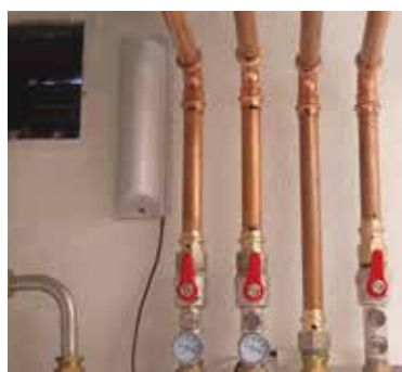
Alf Brolin gjorde själv det mesta av all rördragning.
