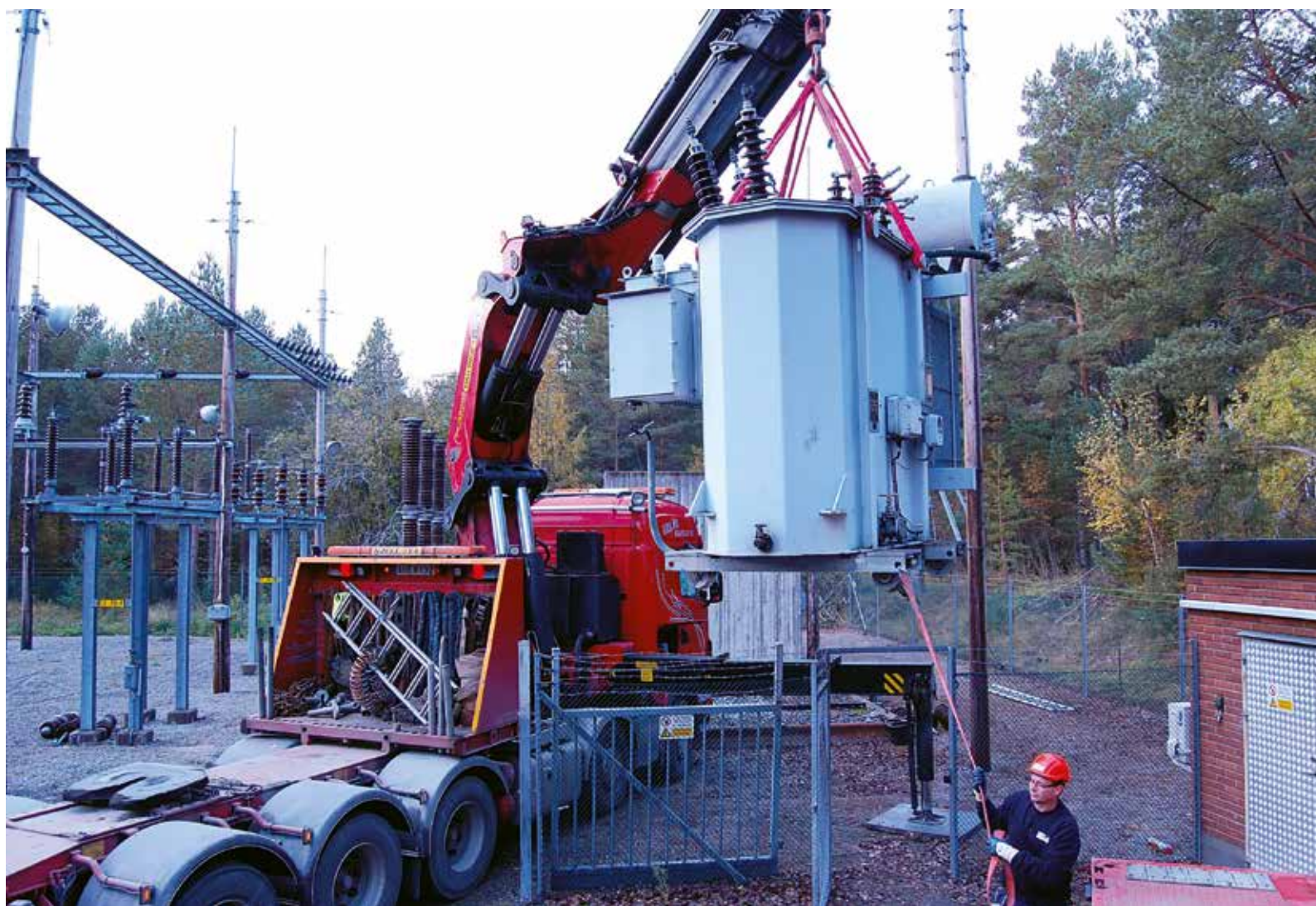
Den 16 ton tunga transformatorn från 1971 har gjort sitt. Nu fraktas den till Stena Metalls specialanläggning för transformatorremontering i Karlstad. Inom kort kommer hela ÖMT att vara borta, kvar blir bara kopplingsstationen som syns i höger i bild.
