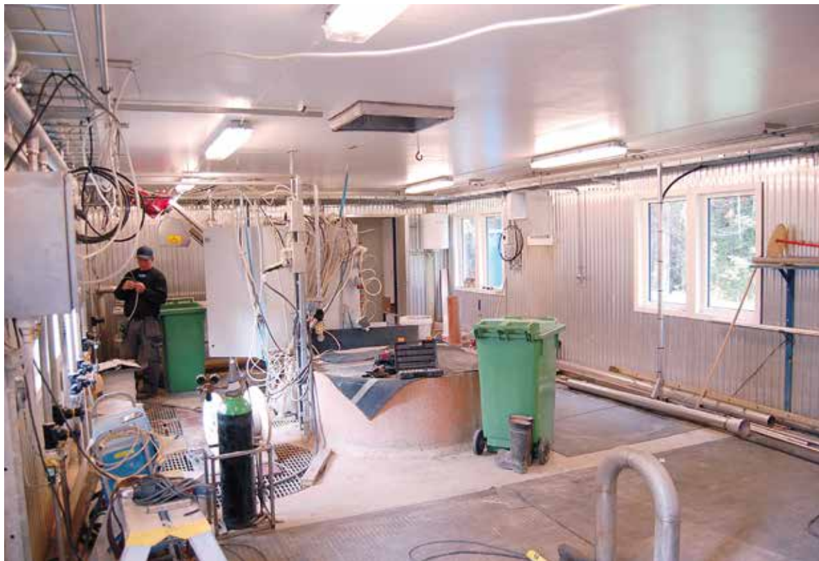
Just nu är hela reningsverket en arbetsplats och i stort sett hela innanmätet ska bytas ut.
