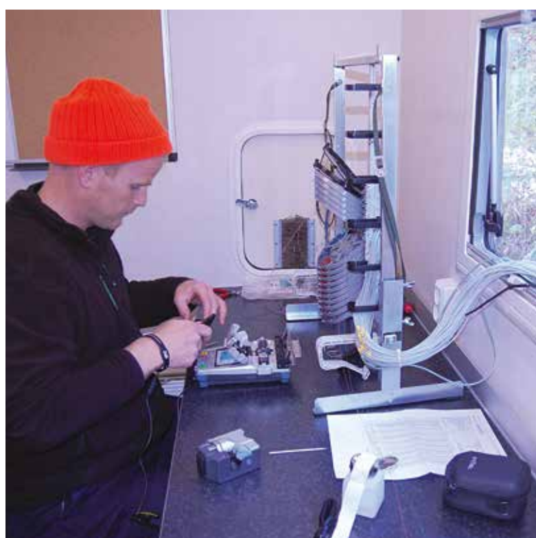
Pär Edquist svetsar samman fiber till alla anslutna hushåll. En kabel för datatrafik och en för TV.
