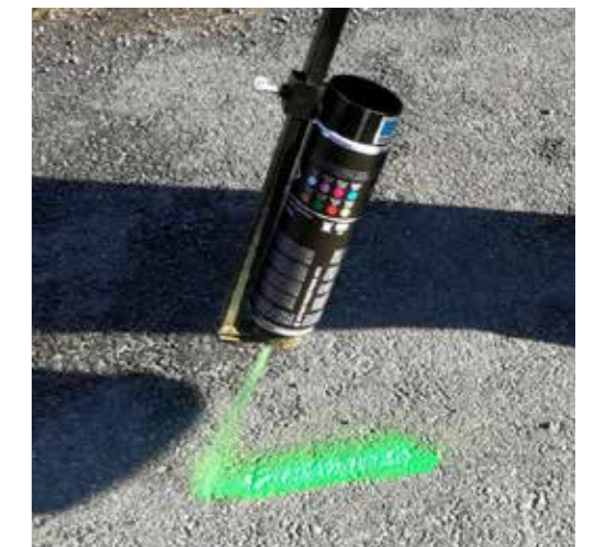
En tydlig färgmarkering gör att du enkelt kan se var du inte bör gräva.
