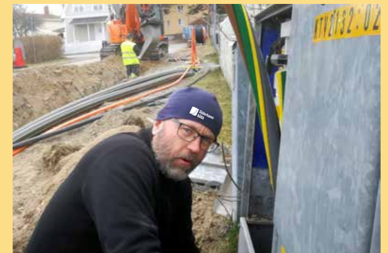
Magnus Lindberg förstärker högspänningsnätet på Matrosgatan. Ett av Söderhamn Närars många grävprojekt under året.
